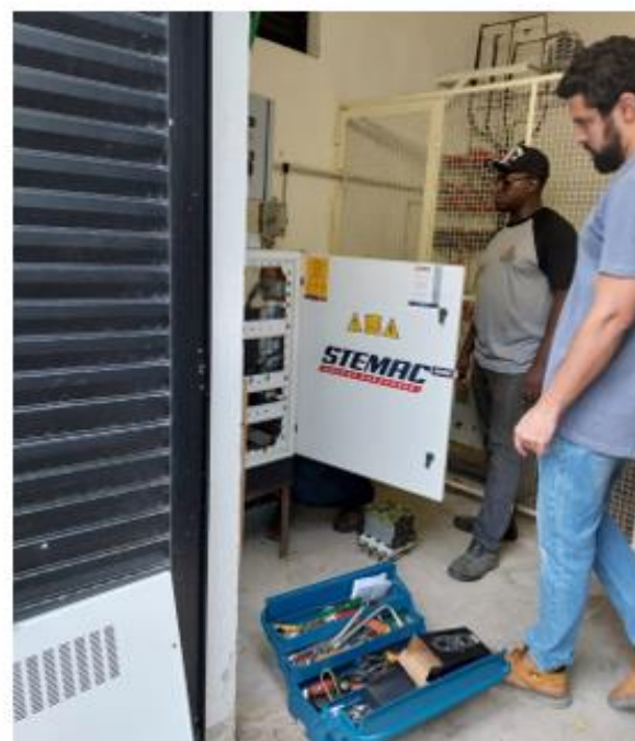
Dia 12/09/2022 - Substituição de Contator para acionamento do gerador do Bloco E (Instituto Biomédico) no Campus Valonguinho.
