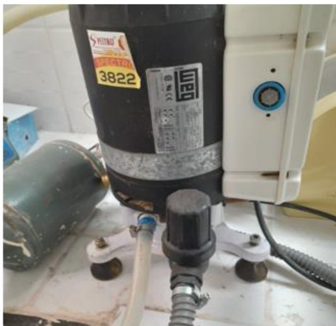
Dia 23/09/2022 – Instalação de 03 (três) bombas hidráulicas para atendimento da Clínica nº 01 da Faculdade de Odontologia no Campus Valonguinho.
