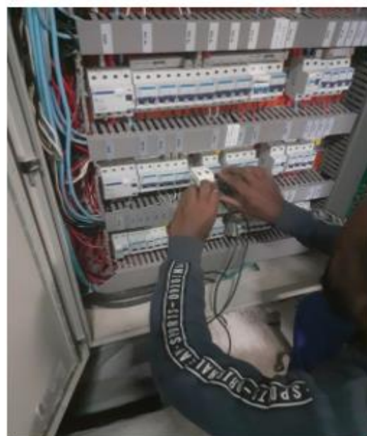
Dia 12/09/2022 - Instalação de disjuntor e tomada 220v na sala 503 do Instituto Biomédico no Campus Valonguinho.
