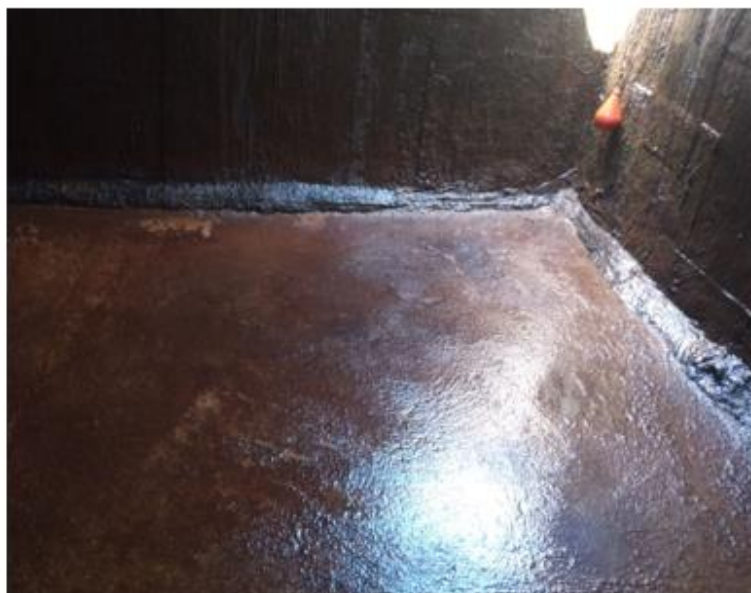
Dia 02/09/2022 - Limpeza de cisterna d'água que atende à Biblioteca Central do Valonguinho e ao DCE no Campus Valonguinho.
