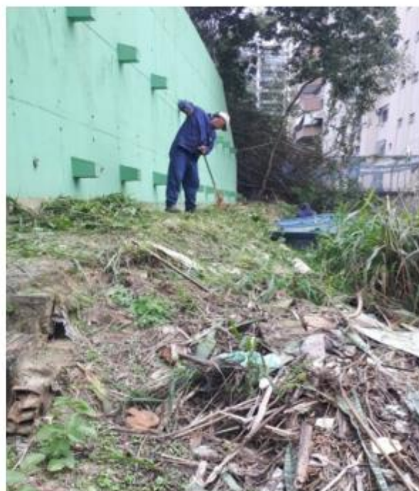
Dia 22/09/2022 - Roçada próximo ao muro de proteção da Encosta da Reitoria.
