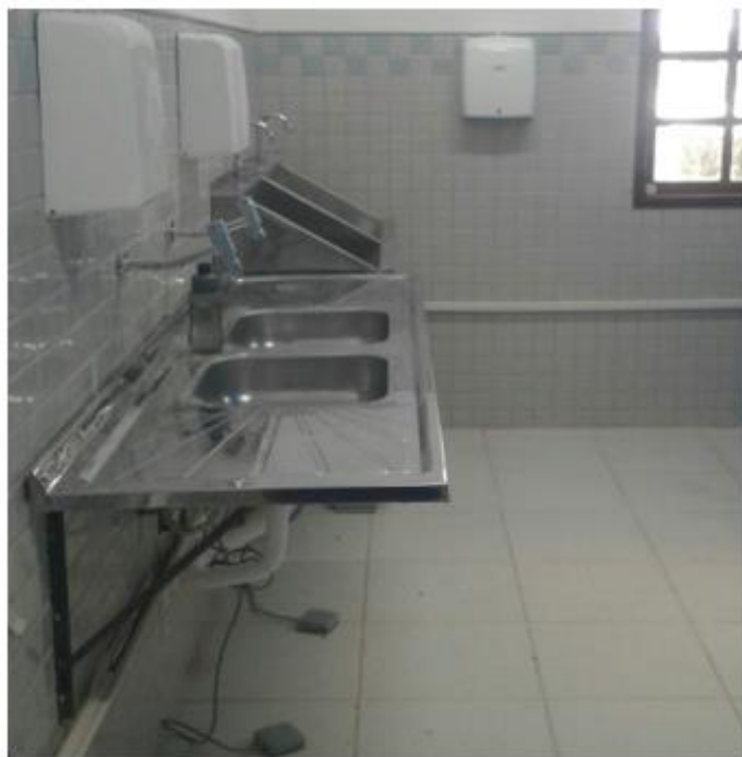
Dia 21/09/2022 - Instalação de pedais elétricos para pias na Sala da Enfermagem no IHS em Rio das Ostras.
