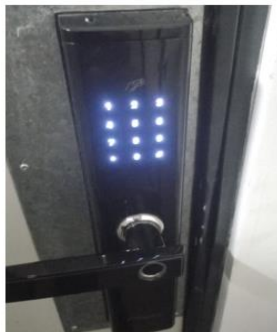
Dia 20/09/2022 - Instalação e configuração de fechadura eletrônica na Escola de Arquitetura e Urbanismo no Campus Praia Vermelha.
