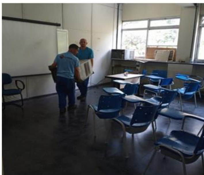
Dia 09/09/2022 - Retirada de aparelhos de ar condicionado, tipo split, na Faculdade de Direito para viabilizar nova instalação.
