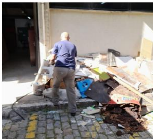
Dia 04/05/2022 - Retirada de madeira e entulho na Escola de Engenharia no Campus Praia Vermelha.
