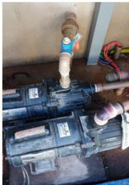
Dia 04/05/2022 - Realizada manutenção de bomba d'água no IHS em Rio das Ostras.
