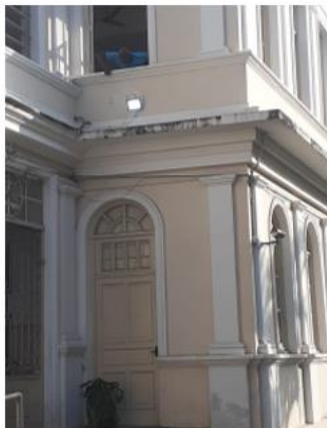
Dia 10/05/2022 - Instalação de refletores no pátio da Faculdade de Direito I.
