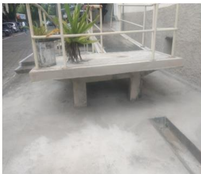
Dia 30/05/2022 - Instalação da rampa de acesso ao Departamento de Morfologia no Campus Valonguinho.
