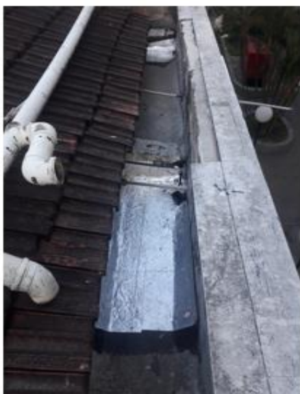
Dia 03/05/2022 - Aplicação de prime em todo o beiral na parte superior do Laboratório de pescado no Campus Valonguinho.
