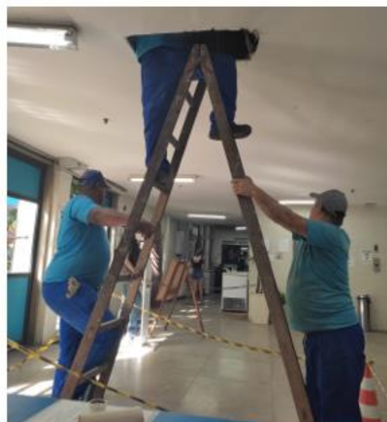
Dia 10/05/2022 - Troca da tubulação do ralo no 1º andar do Instituto de Geociências no Campus Praia Vermelha.
