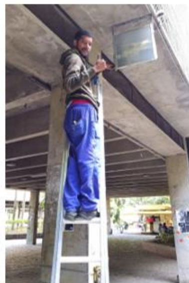
Dia 19/05/2022 – Substituição de lâmpadas no Campus Gragoatá.
