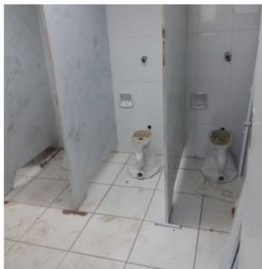
Dia 03/05/2022 - Retirada de Louças em banheiro do 5º andar do prédio da Faculdade de Nutrição no Campus Valonguinho.
