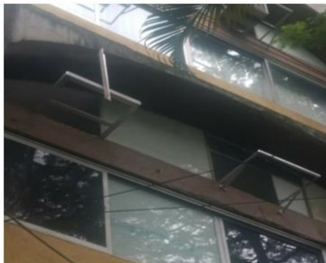
Dia 10/05/2022 - Instalado 03 (três) suportes de aparelhos de ar condicionado no 3º andar prédio do STI no Campus Valonguinho.
