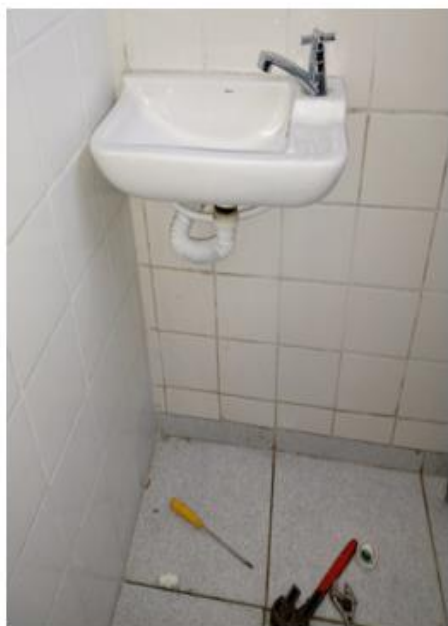
Dia 23/05/2022 - Troca de uma torneira na Faculdade de Medicina localizada no Hospital Universitário Antônio Pedro.
