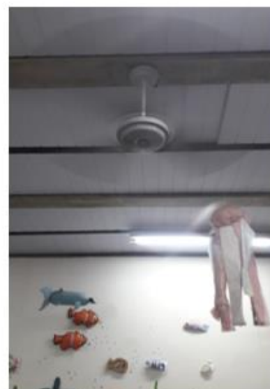
Dia 10/05/2022 - Troca de 03 (três) capacitores dos ventiladores de teto na sala nº 219 do Bloco D no Campus Gragoatá.
