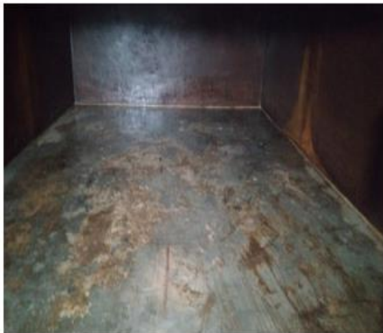
Dia 20/05/2022 - Limpeza de cisterna no Mequinho.
