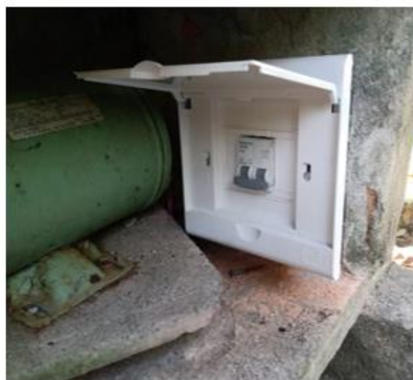
Dia 04/05/2022 - Troca de quadro de disjuntor da bomba d'água do Bloco E em Campos dos Goytacazes.
