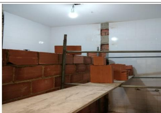
Andamento da construção de banheiro e sala da auditoria técnica no Gragoatá.
