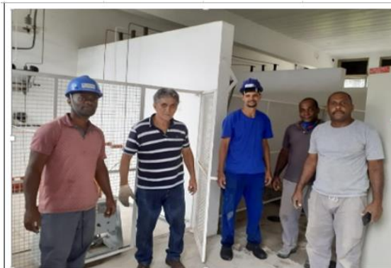
Recuperação da subestação de energia da UFASA, no bloco H, Praia Vermelha, após uma pane geral.
