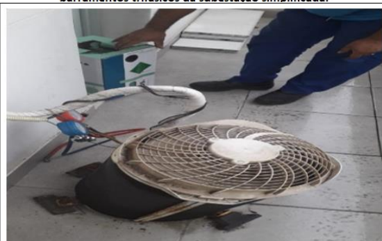
Foram atendidas todas as solicitações de manutenção de equipamentos de refrigeração do 4º andar da Reitoria.
