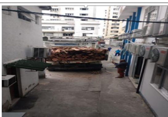
Serviço de retirada dos troncos de eucaliptos encerrados parcialmente nos fundos da Reitoria. Previsão da conclusão do serviço é 06/02/2020.
