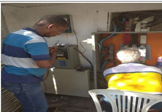
Serviço de substituição de disjuntor geral de 800A e adaptação de barramentos trifásicos da subestação simplificada.
