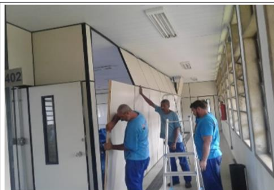
Recolocação de divisórias no 4º andar do bloco H da Praia Vermelha
