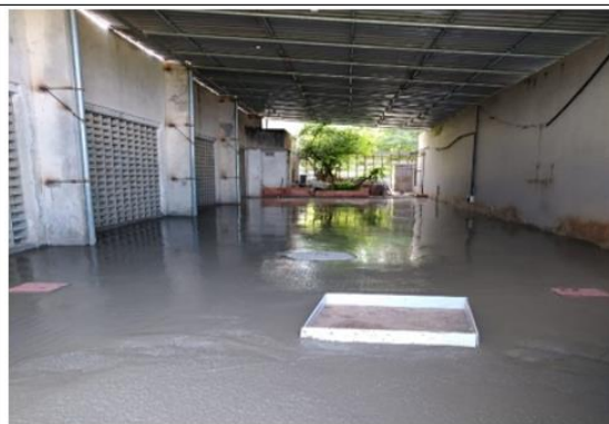
Concreto usinado no almoxarifado. Piso com 130 m². Concreto bombeado em 1 hora de execução - Campus Gragoatá.
