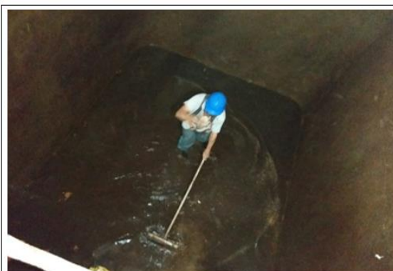
Limpeza cisterna do bloco c biomédico do Valonguinho.
