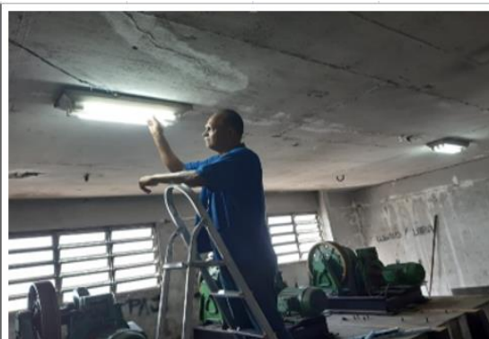
Iluminação da casa de máquina dos elevadores da administração 1 concluído no Valonguinho.
