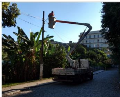
Troca lâmpadas dos postes: Campis Praia Vermelha e Gragoatá.
