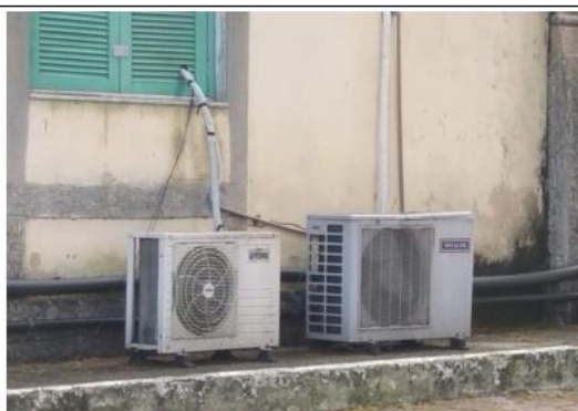
Ligação de condensadora - Física Velha
