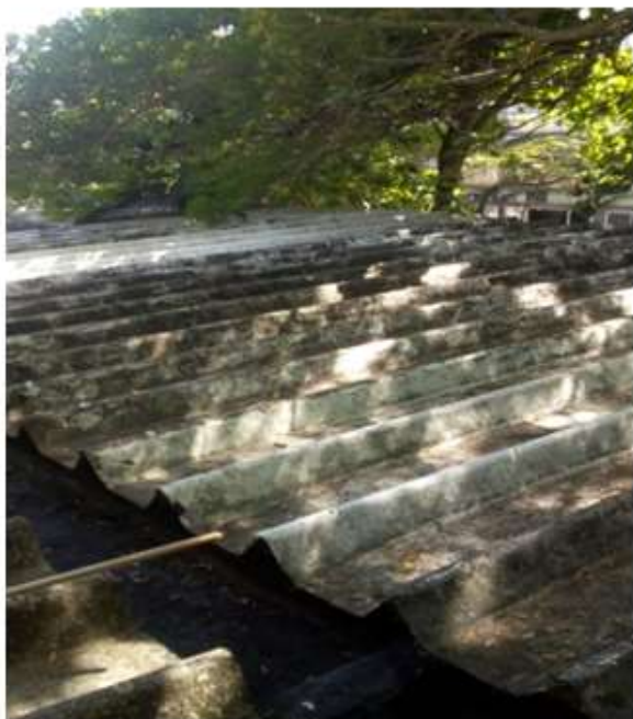
Dia 03/12/2020 - Limpeza do telhado, calhas e a descidas d'água do prédio do INESP no Campus Valonguinho.
