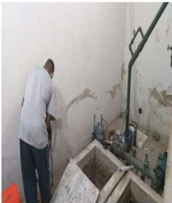
Dia 09/12/2020 - Limpeza da Cisterna da Biblioteca Central do Gragoatá.
