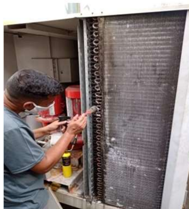
Dia 03/12/2020 - Serviço de recuperação da serpentina do Chiller nº2 do CEART na Reitoria.
