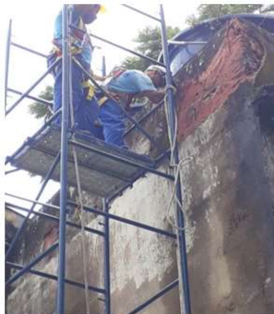
Dia 07/12/2020 - Escariação das paredes para retirada do reboco antigo e aplicação de um chapisco para posterior aplicação de emboço na parede do Prédio Enjoy, o qual é vizinho ao Instituto Biomédico no Campus Valonguinho.
