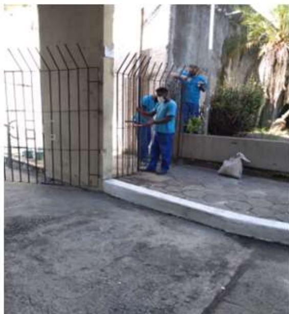
Dia 04/12/2020 - Raspagem das ferragens das grades em torno da portaria do Campus Valonguinho.
