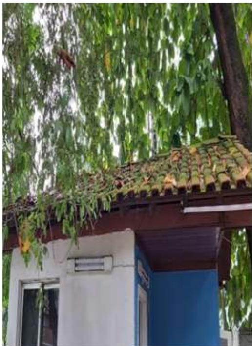
Dia 28/12/2020 - Conserto do telhado da guarita do CRIAA no Barreto.
