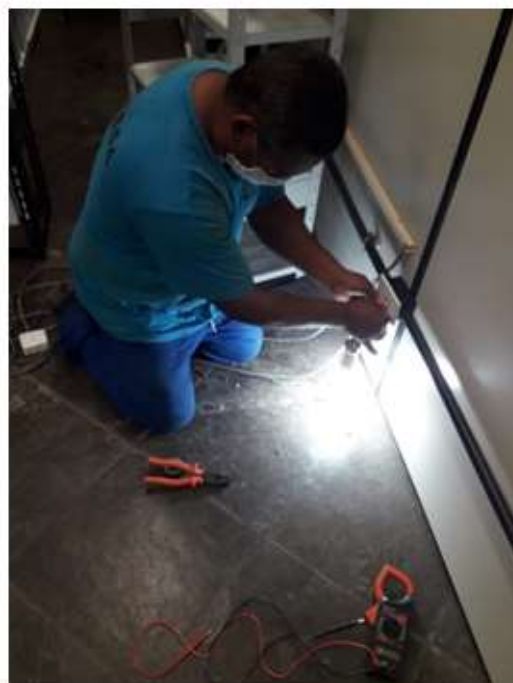
Dia 09/12/2020 - Instalação de um circuito elétrico de tomadas para atender a nova sala do SDC no Campus Gragoatá.
