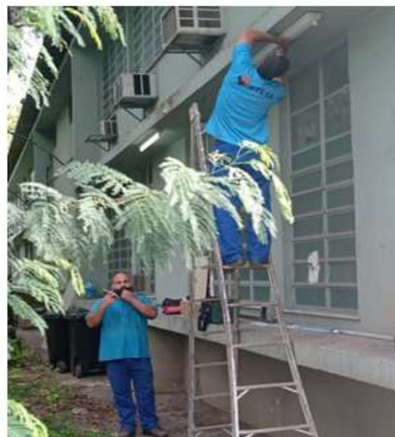
Dia 04/12/2020 - Verificação de todo o circuito de iluminação, com troca de lâmpadas queimadas da Geriatria no Mequinho.
