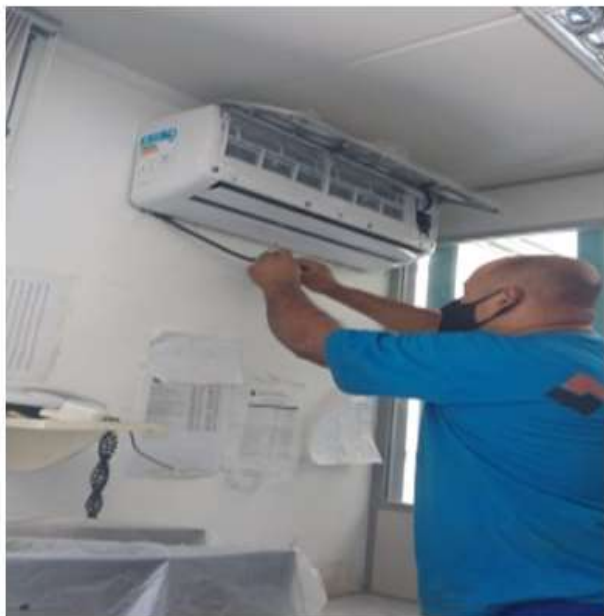
Dia 01/12/2020 - Instalação de aparelhos de ar condicionado Split no 4º andar, setor DAP, Reitoria.
