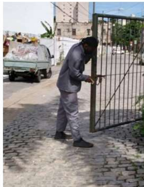
Dia 23/12/2020 - Raspagem, limpeza e pintura das paredes e das grades da guarita principal do Campus Gragoatá.
