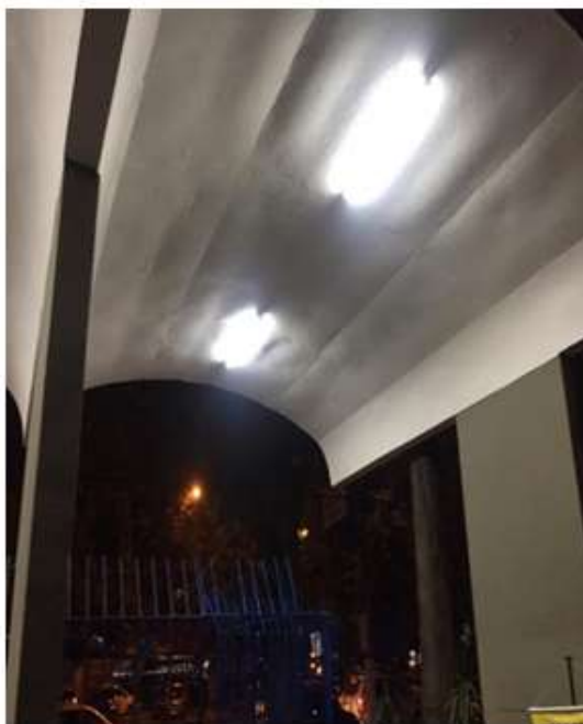
Dia 15/12/2020 - Manutenção do circuito de iluminação e instalação de luminárias na portaria do Valonguinho.
