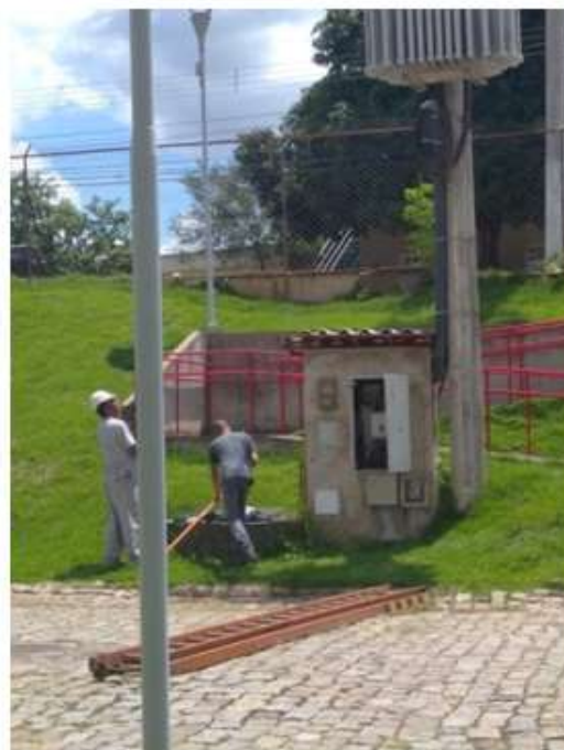
Dia 17/12/2020 - Manutenção Preventiva da Subestação do Instituto do Noroeste Fluminense de Educação Superior - INF em Santo Antônio de Pádua.
