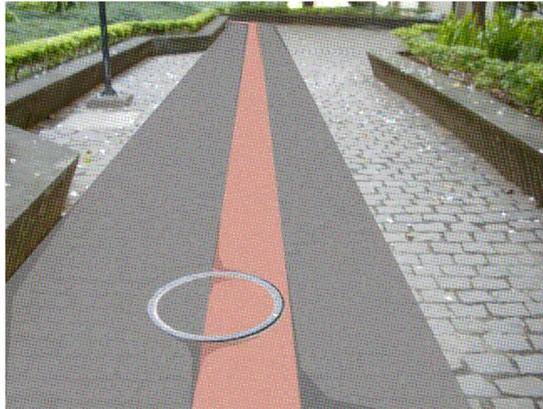
*Figura 7 - Exemplo de caminho a ser executado com tampão revestido com piso podotátil e cimentado.*
